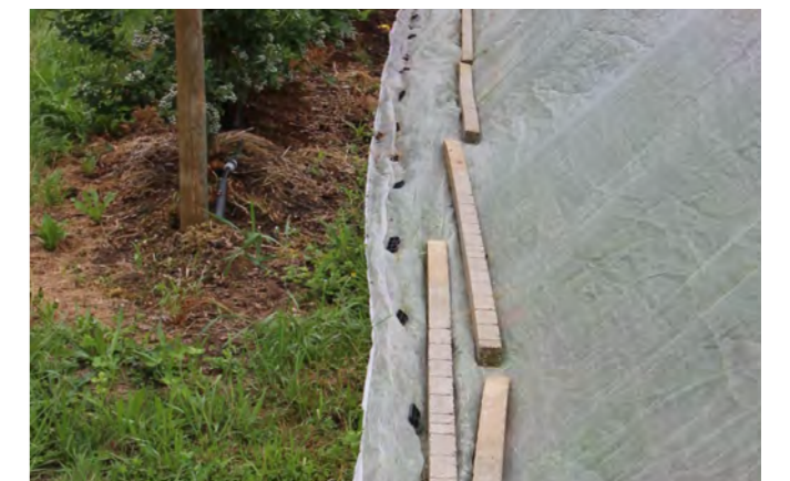
Abb. 30: Ausreichende Beschwerung, jedoch Gefahr von Beschädigung des Netzes Foto: Augel/LTZ
